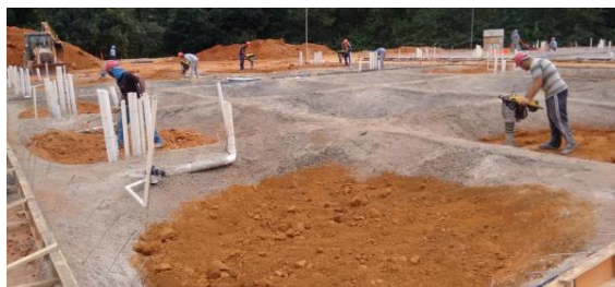
Fig. 13 Backfill the modules
